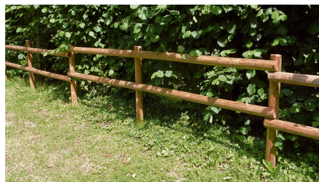
Une clôture avantageuse en rondins avec des traverses en demi-ronds, fixées avec des tire-fond
